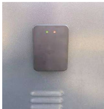
(d) Front display after installation
