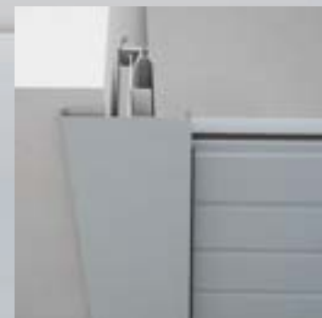
Монтаж в отворі – маскування перед отвором
